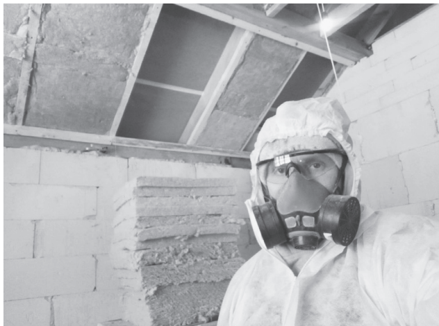
Ремонт в жилище требует серьезной экипировки.
